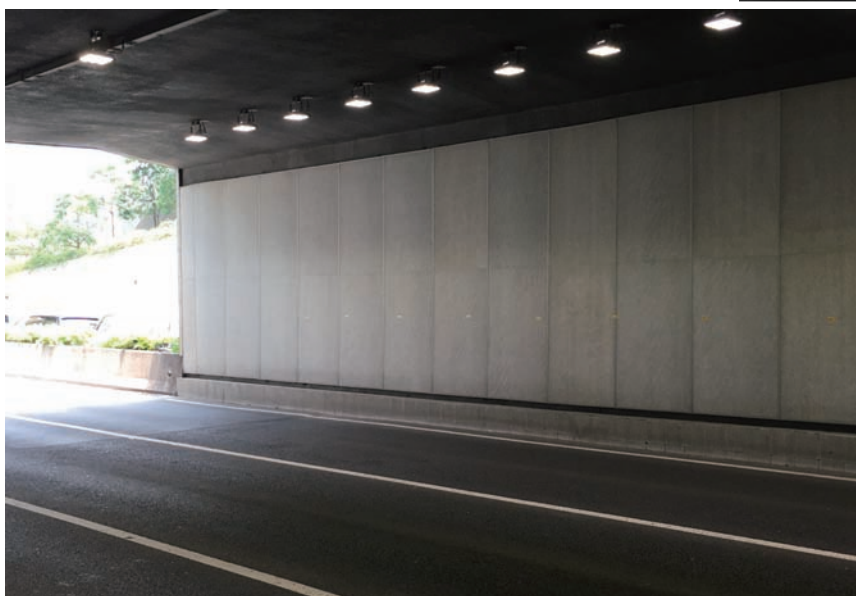
广州花城汇隧道 Guangzhou CBD Tunnel
